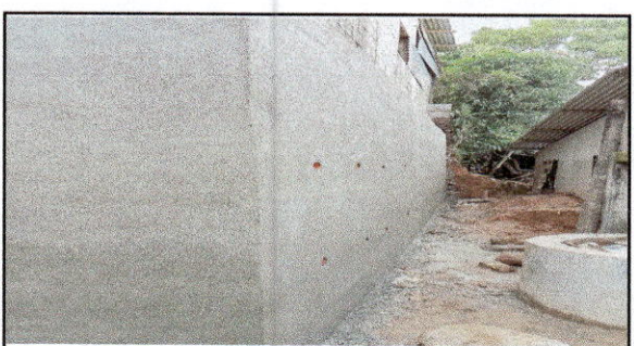
FOTO 6: Reparación de muro de contención
