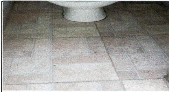
FOTO 1: Sustitución de piso de cemento líquido por piso ceramico
