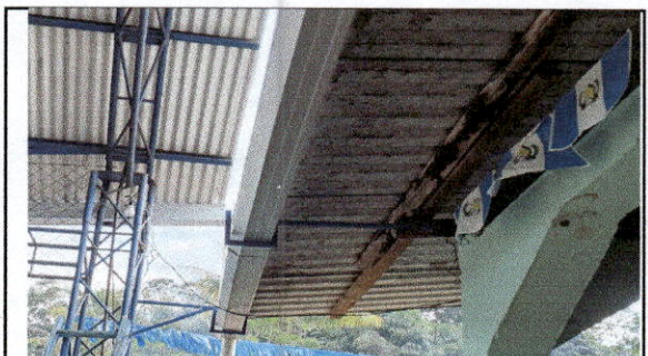
FOTO 4: Sustitución de canal de metal En modulo de aulas
